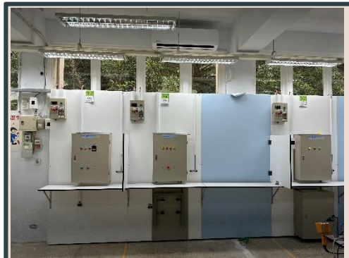
室內配線乙級第二站
